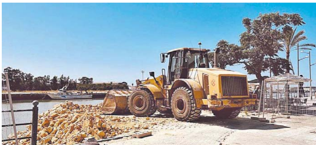
Las obras de construcción de la nueva pasarela se retomaron en mayo y se encuentran paradas desde principios de verano.
